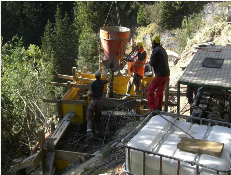
**Betonieren des Widerlagerblockes orografisch rechts**
