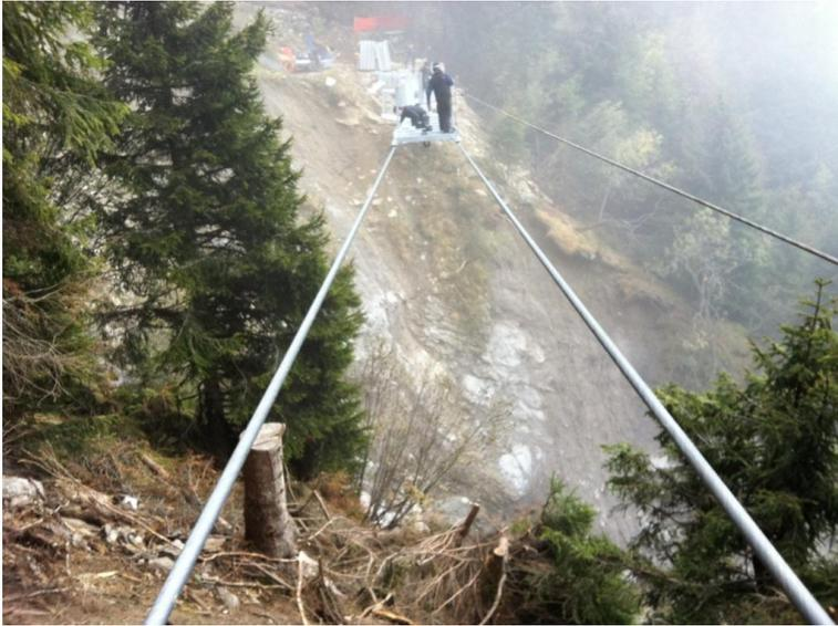
**Eingebaute Spannseile und Einbau der Brückenelemente**
